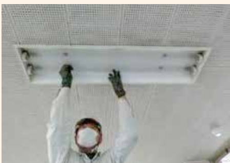
蛍光灯の反射板の取り外し
